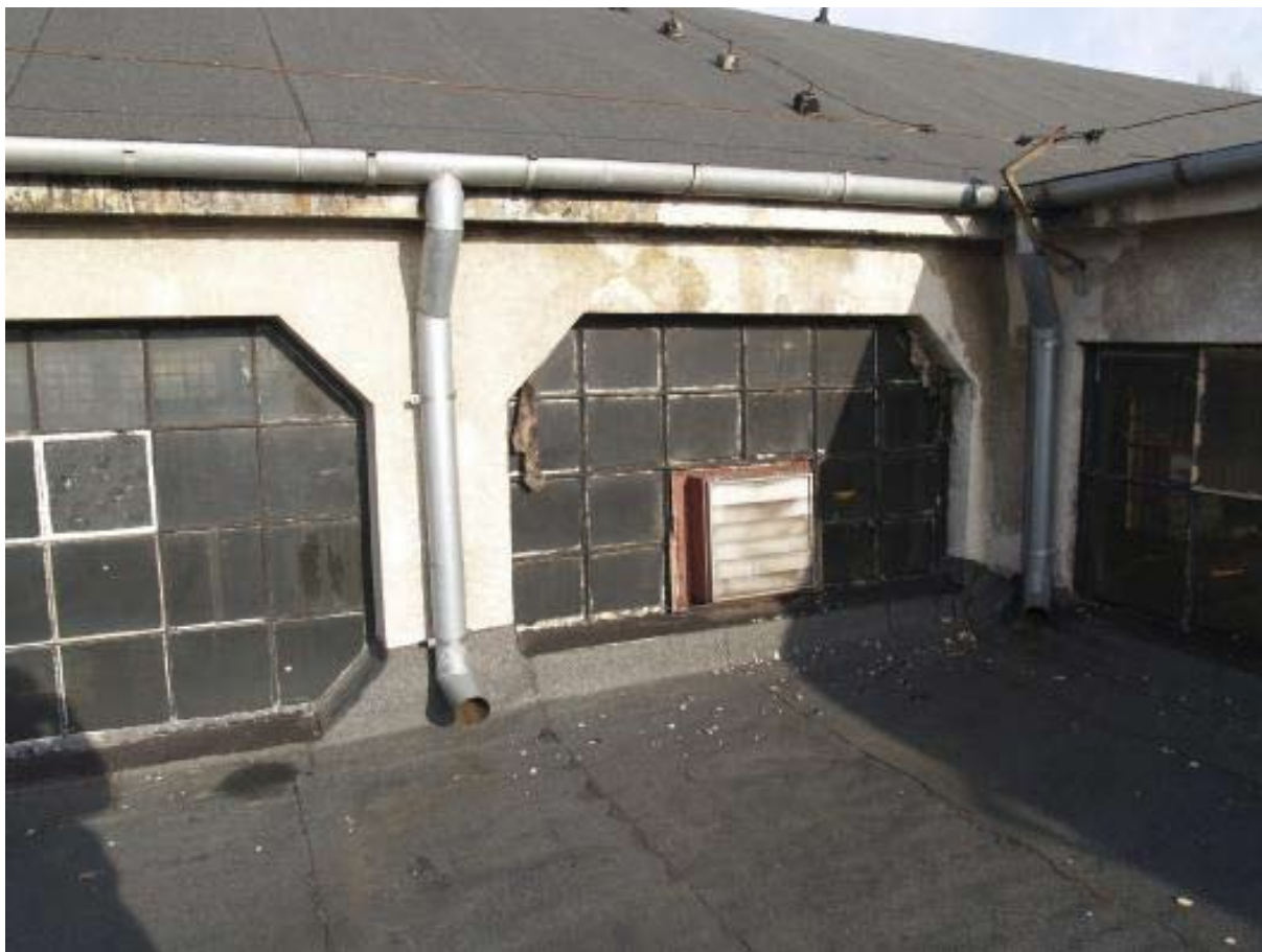
Foto 33. Widok na dach z kratownicą Wilandera na stronę wschodnią.
