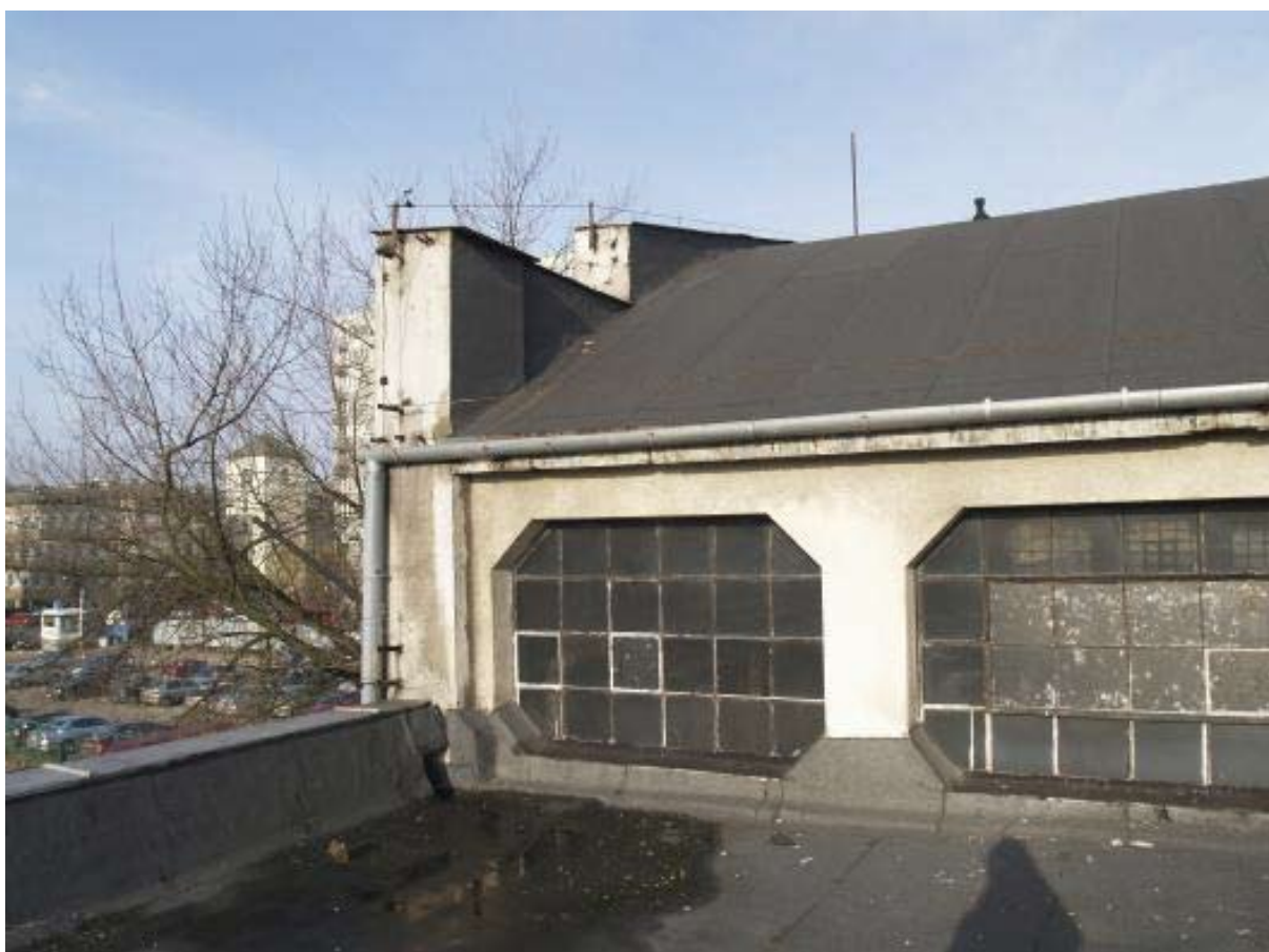
Foto 32. Widok na dach i kratownicę Wilandera od strony południowozachodniej.
