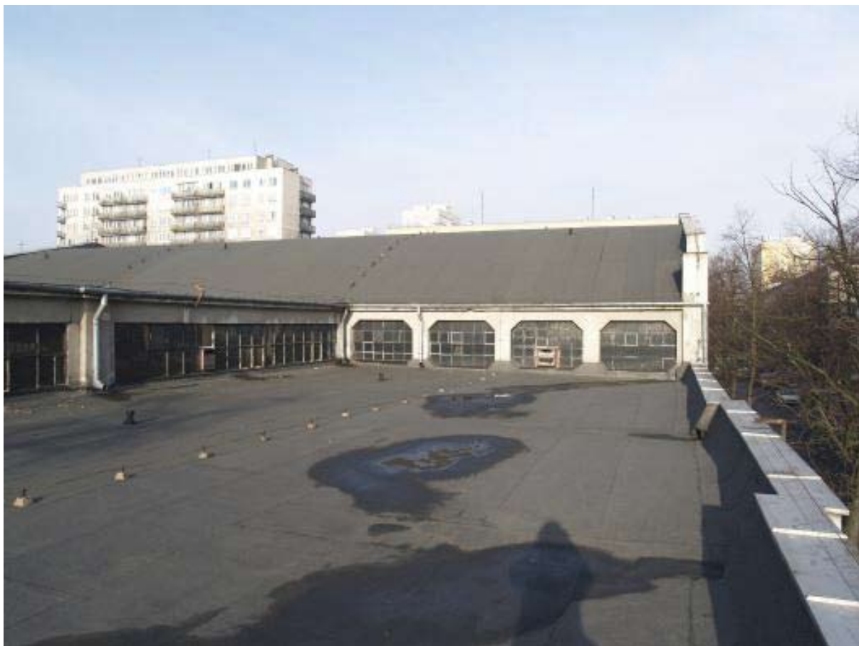
Foto 29. Widok na dach od strony południowej.
