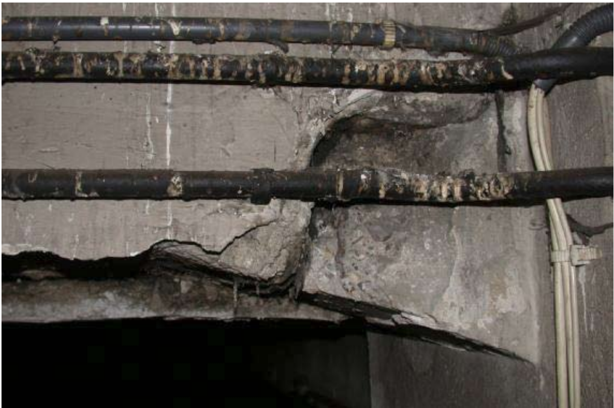
Foto 54. Wspornik żelbetowy belki.
