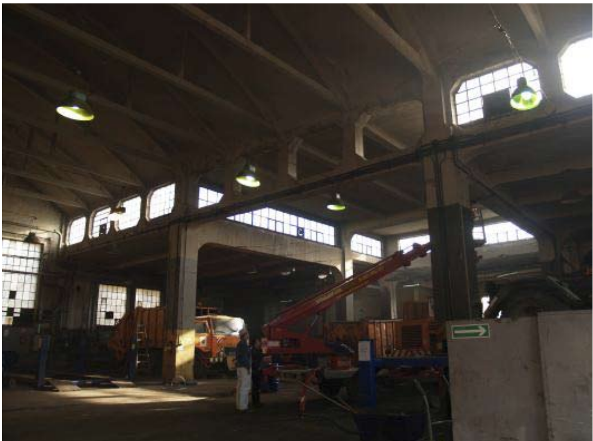
Foto 36. Część „wysoka” hali oraz widok na kratownicę „Wilandera” i stronę skrzydła południowego.
