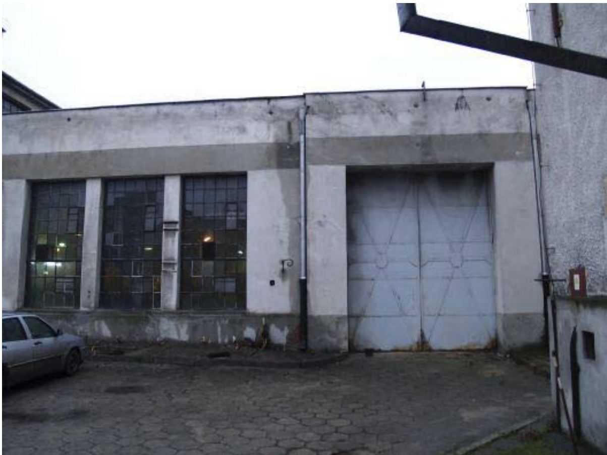
Foto 3. Widok na bramę i okna części niskiej.
