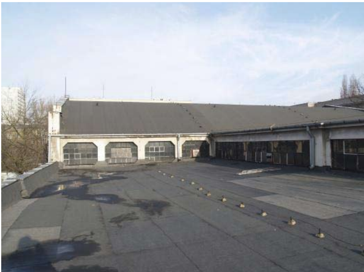
Foto 28. Widok na dach od strony zachodniej.
