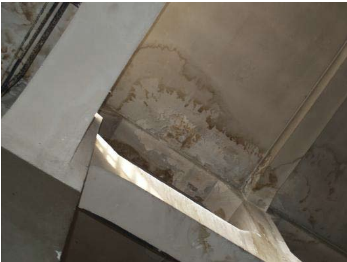
Foto 45. Zawilgocenie dachu.
