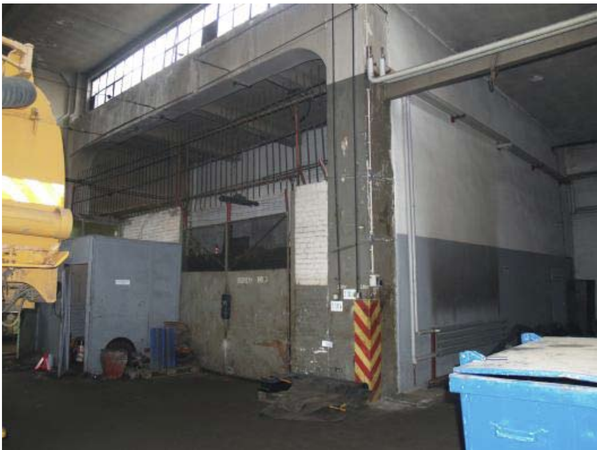
Foto 41. Skrzydło północne z fragmentem korytarza w kierunku bramy nr 3.
