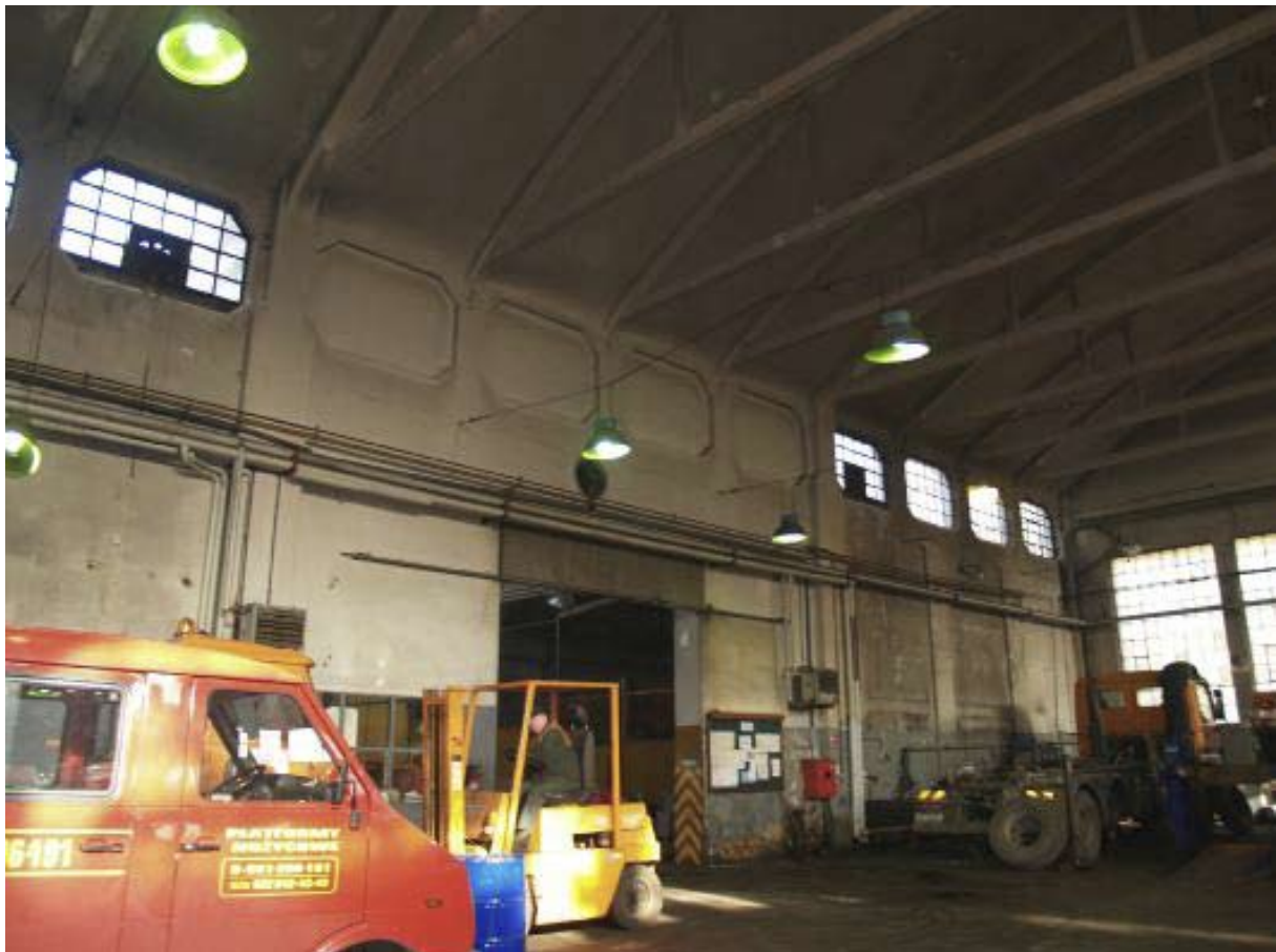
Foto 37. Widok na stronę skrzydła północnego budynku.
