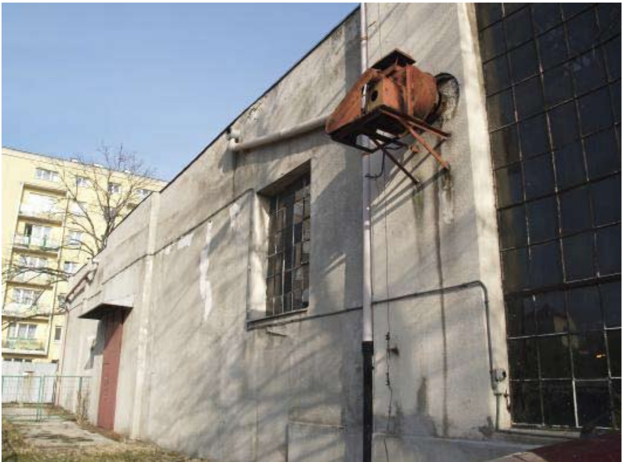
Foto 10. Widok na lewe skrzydło elewacji frontowej.
