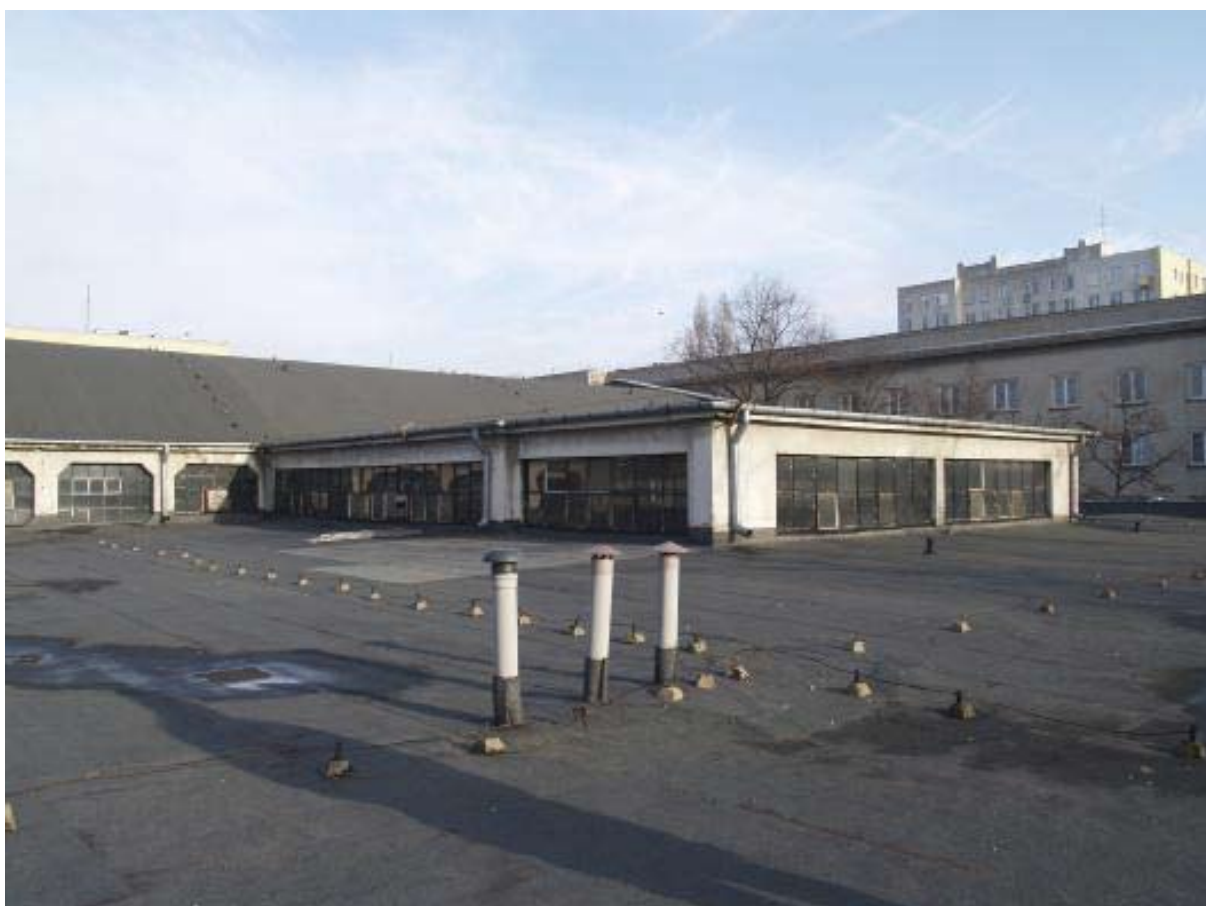
Foto 30. Widok na dach od strony południowo-zachodniej.
