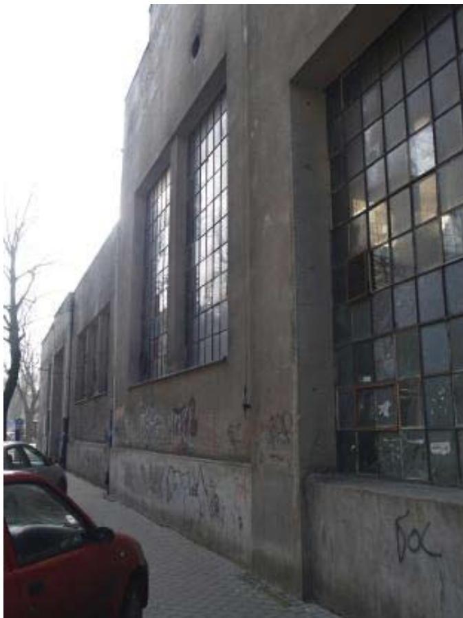
Foto 22. Widok elewacji zachodniej.
