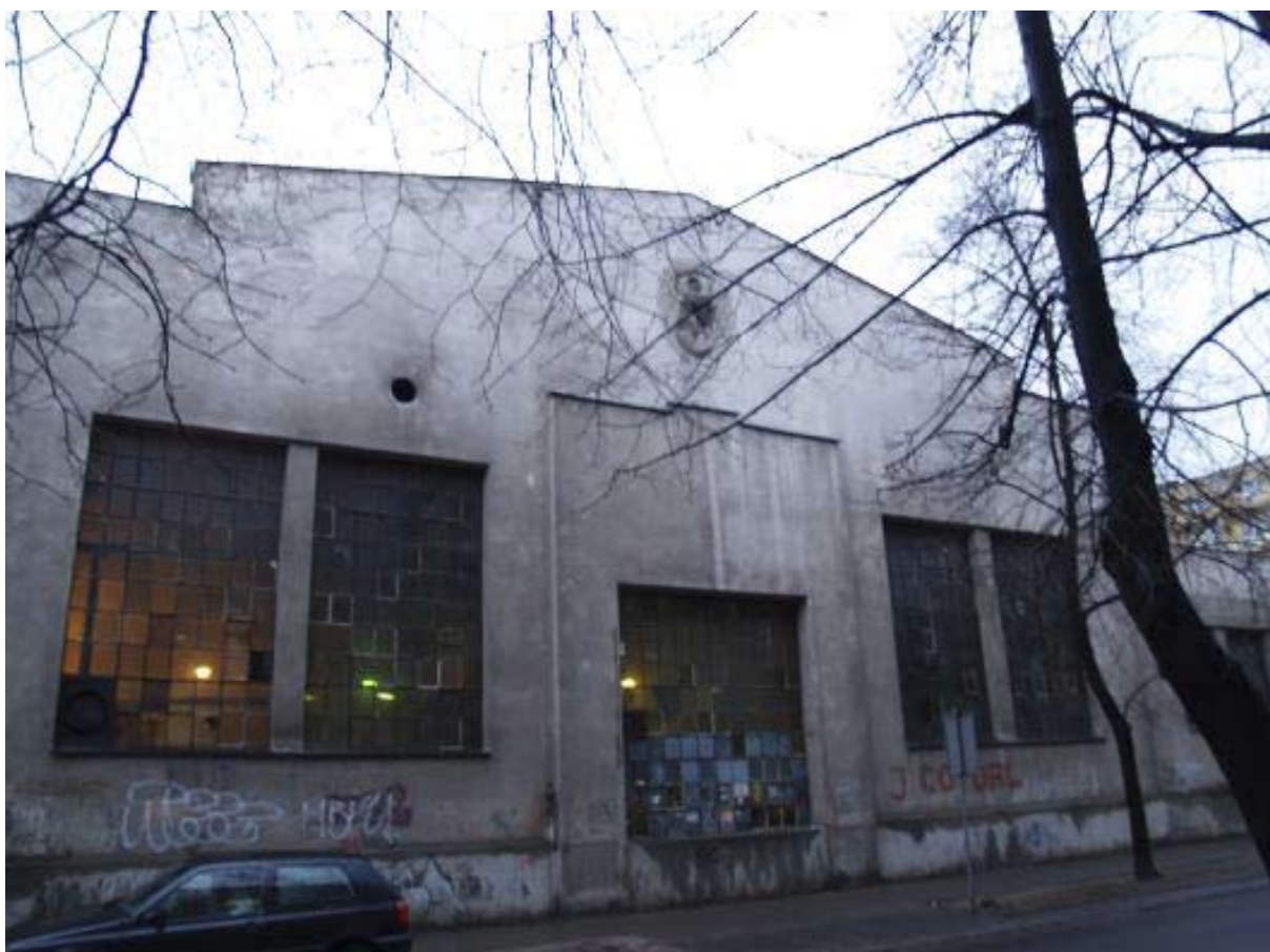
Foto 16. Część centralna (dominanta) elewacji od ulicy Sandomierskiej.
