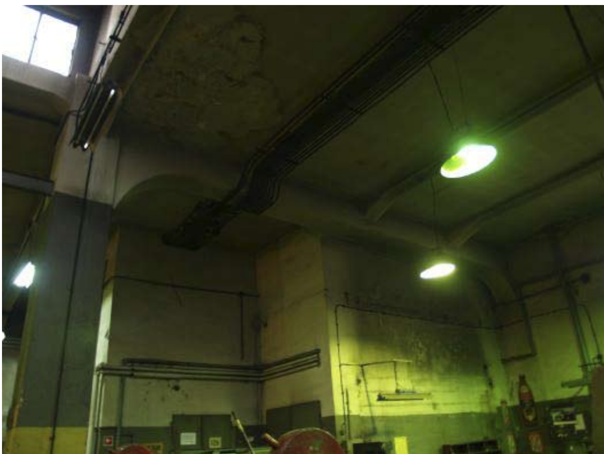
Foto 42. Skrzydło południowe –widok na narożnik ścian (wejście do rozdzielni elektrycznej).
