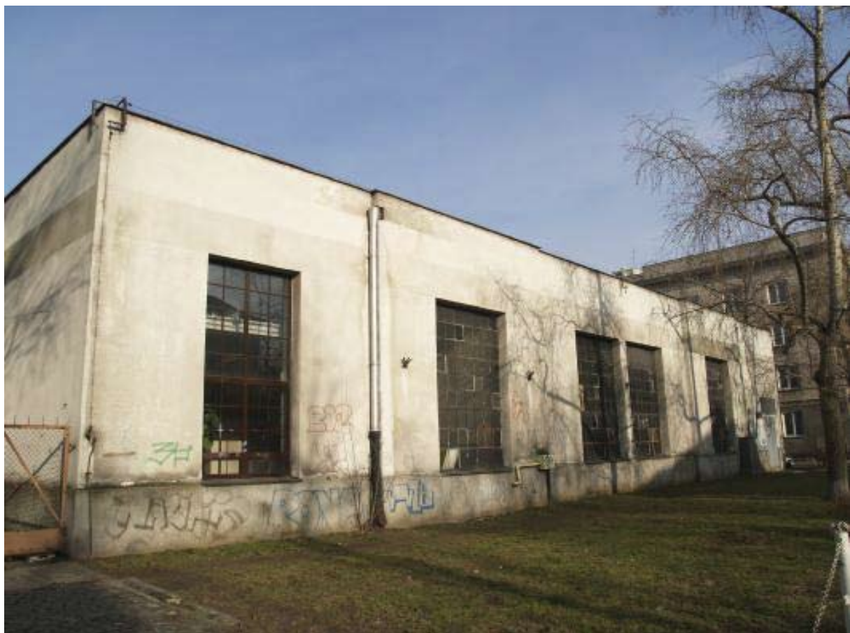
Foto 12. Elewacja od ulicy J. Madalińskiego.
