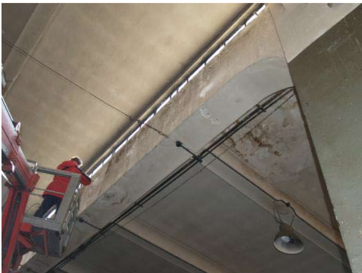
Foto 44. Skrzydło południowe–belki z doświetleniem bocznym hali.
