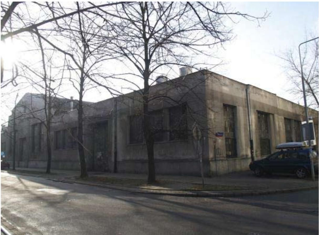
Foto 24. Widok na narożnik elewacji od ulicy Sandomierskiej i Melsztyńskiej
