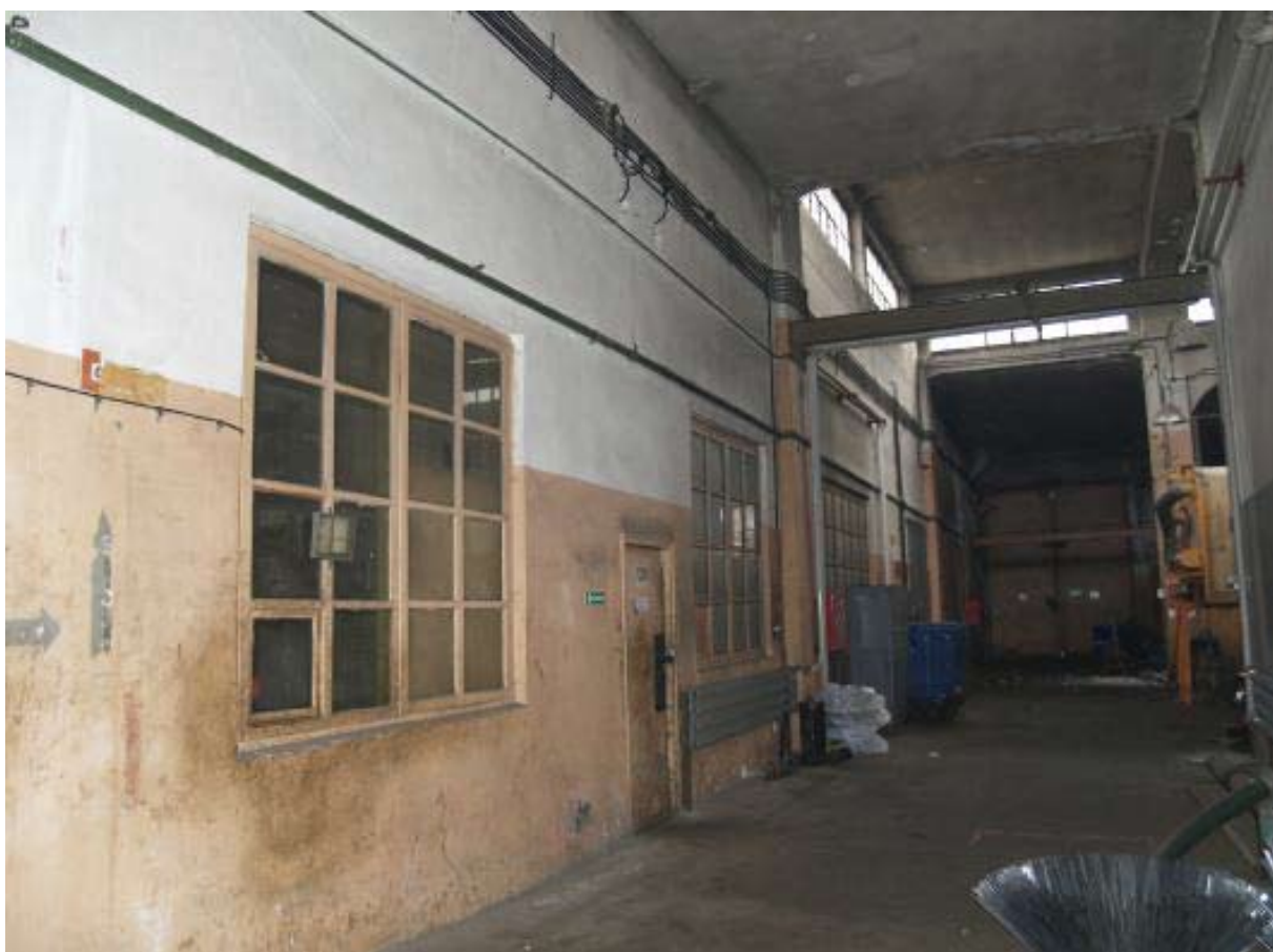
Foto 50. Widok na korytarz części skrzydła północnego budynku.
