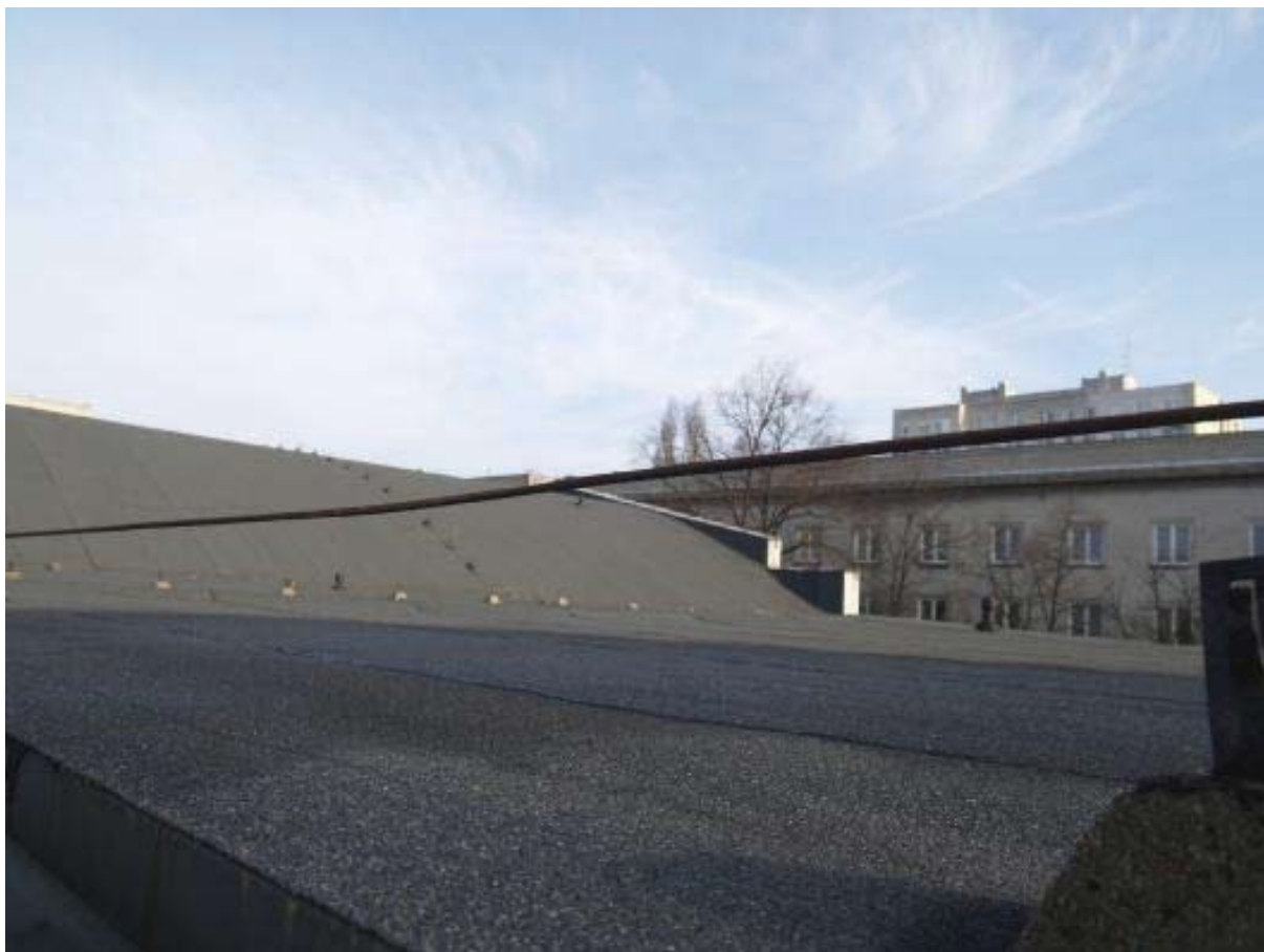
Foto 31. Widok na dach części wysokiej budynku.
