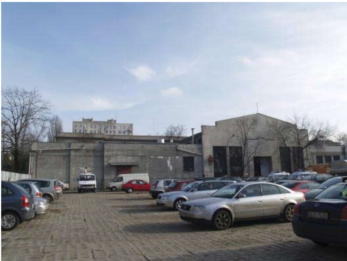
Foto 1. Widok na elewację frontową od strony dziedzińca.
