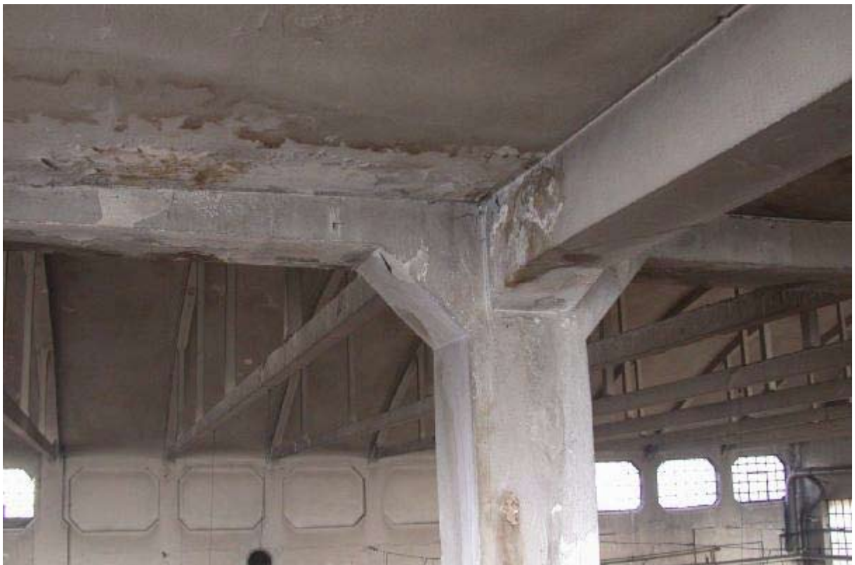
Foto 57. Zawilgocenie stropu.
