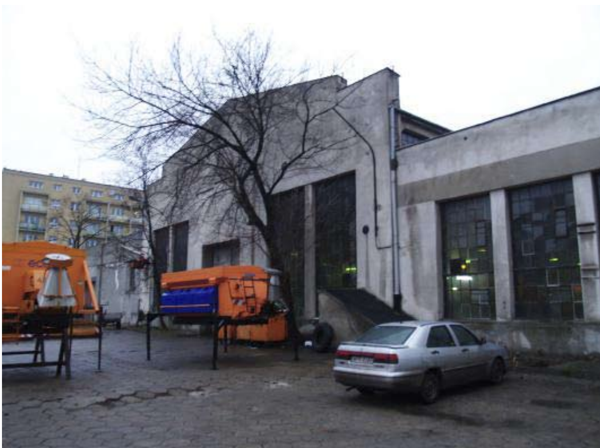
Foto 2. Elewacja wejściowa (zbliżenie na część centralną).
