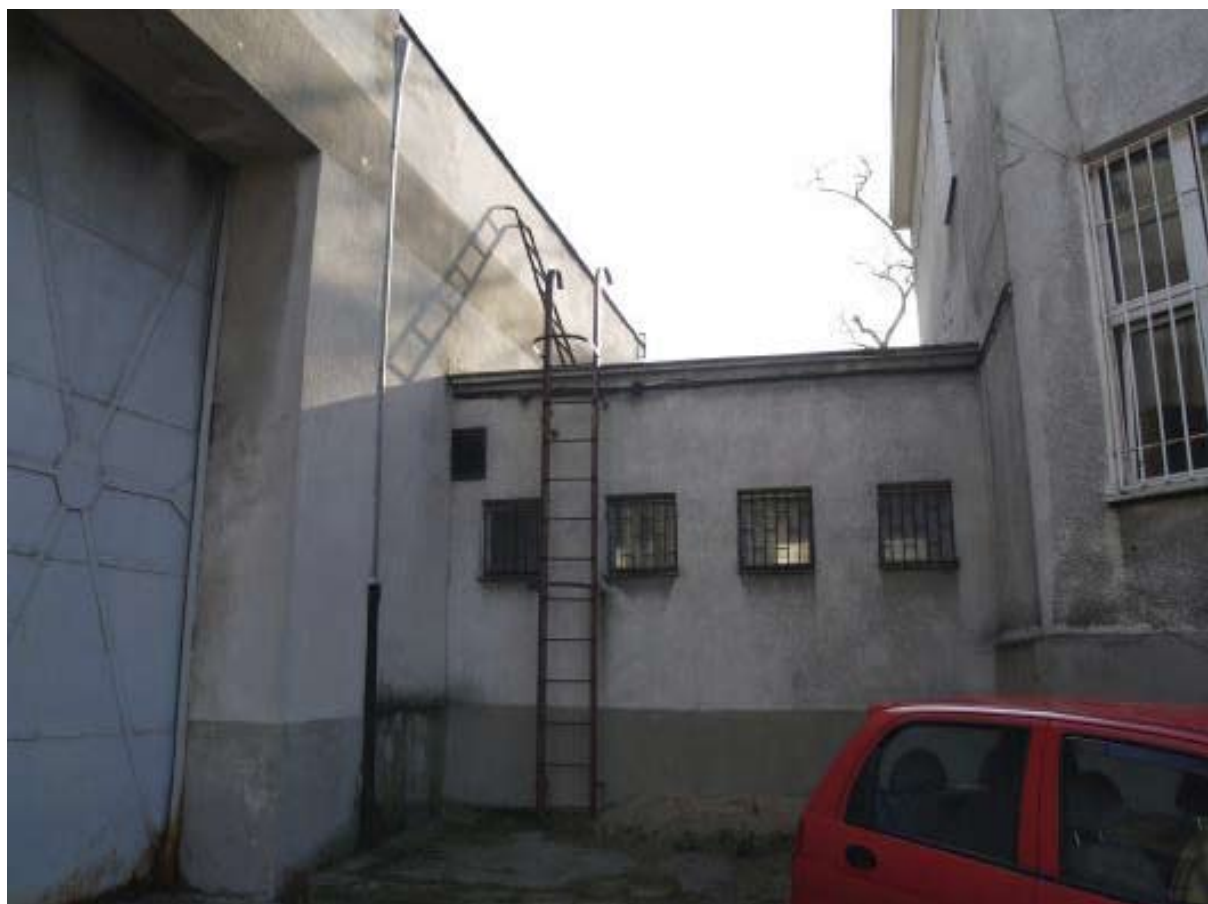
Foto 4. Łącznik z budynkiem hali.
