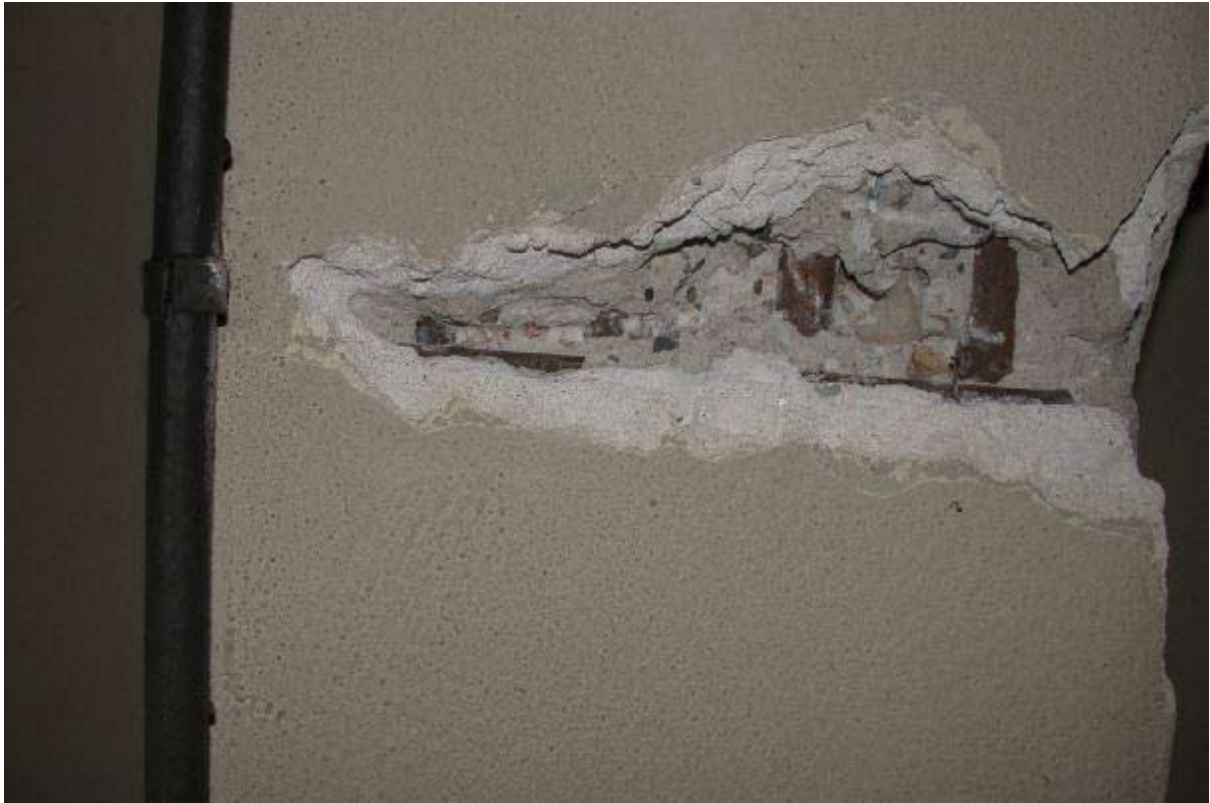
Foto 64. Odkrywka zbrojenia belki w osiach A-B.
