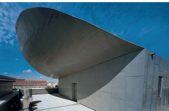
Dom Prasy, pracownia Jo. Franke Architekten BDA, Frankfurt, Niemcy, technologia dużej łuski.
