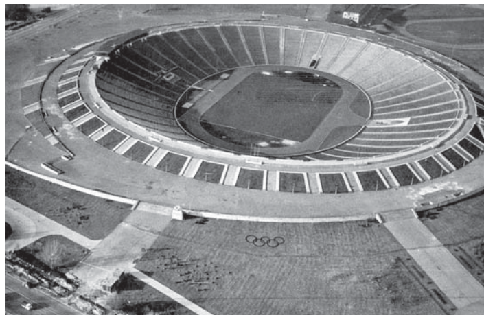
Stadion Dziesięciolecia – unikalną widownię wykonano tylko przy pomocy mas ziemnych
