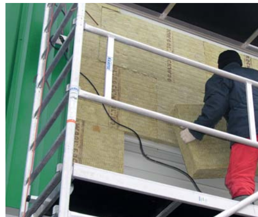
Montaż – płyty z wełny skalnej ściśle przykrywają złącza kaset ściennych
