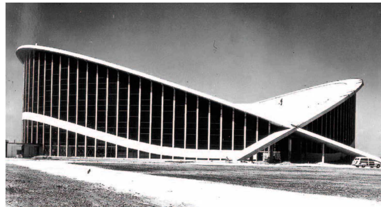
DORTON ARENA TUŻ PO UKOŃCZENIU, 1953 / REPR. ZA ARCHIWUM NCSU
