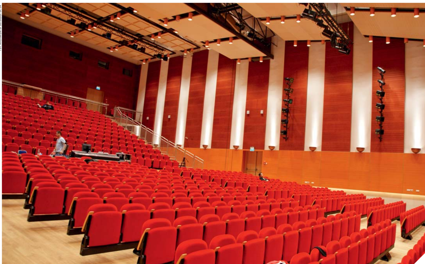
„Matecznik Mazowsze” w Karolinie, sala widowiskowa, widok ściany i sufitu z rozmieszczeniem ustrojów akustycznych (architektura: Biuro Projektów Budownictwa Ogólnego Budopol SA – Lech Jacek Hinc, Waldemar Hinc)
