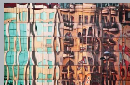
Efekt zniekształcenia obrazu na fasadzie, spowodowany zjawiskiem roller waves
