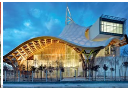
Center Pompidou, Metz, Francja
