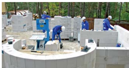
Budowa domu pasywnego z bloczków Solbet
