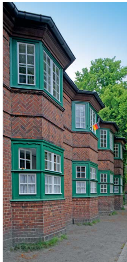
Fragment zabudowy placu przy kościele i szkole
