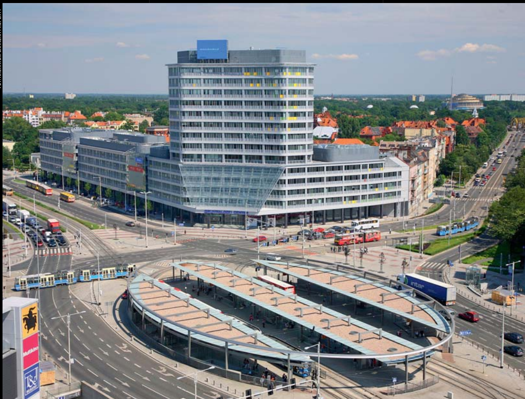
Kompleks Grunwaldzki Center przy Rondzie Ronalda Reagana we Wrocławiu. Miejskowy plan zagospodarowania przestrzeni (autorstwa m.in. architektów dr inż arch. Tomasza Ossowicza i dr inż. arch. Jacka Barskiego), wyznaczył ukształtowanie połowy obwodu ronda w formie dwupiętrowej fasady o nachyleniu 60°. Jest to przykład projektowania architektury już na etapie projektowania planu miejscowego
