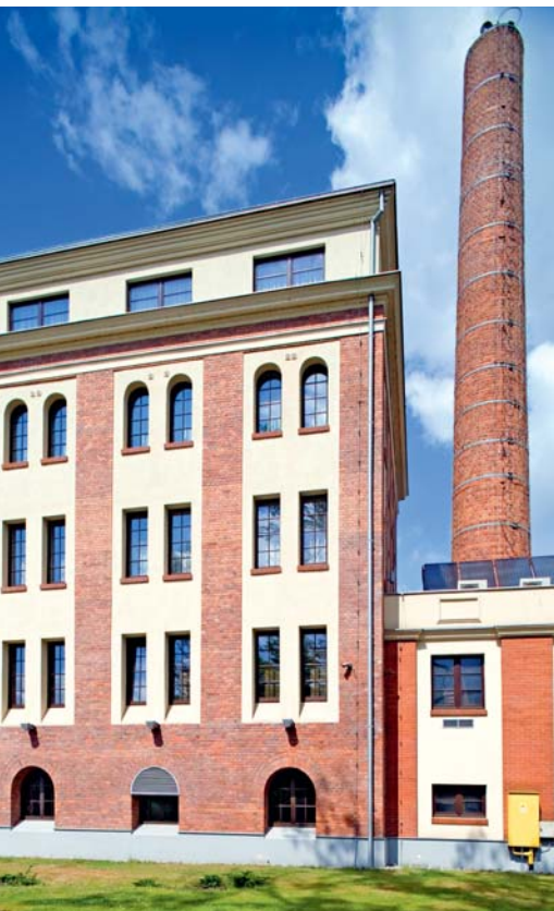
Skrzydło wschodnie hotelu z zachowanym kominem
