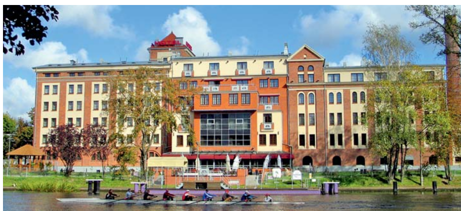
Widok na młyny od strony Brdy – elewacje południowe przed i po rewitalizacji
