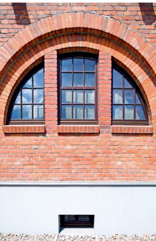
Detal architektoniczny nawiązujący do oryginalnej zabudowy młyna
