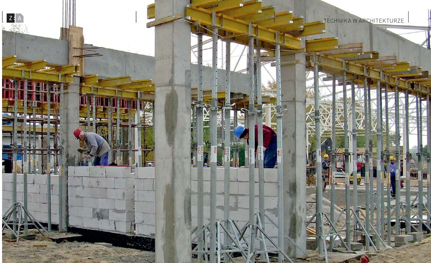
▣ Obiekt, do którego budowy wykorzystano bloczki betonu komórkowego
