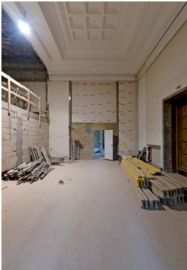
Historyczny sufit w przejściu do Sali Kameralnej
