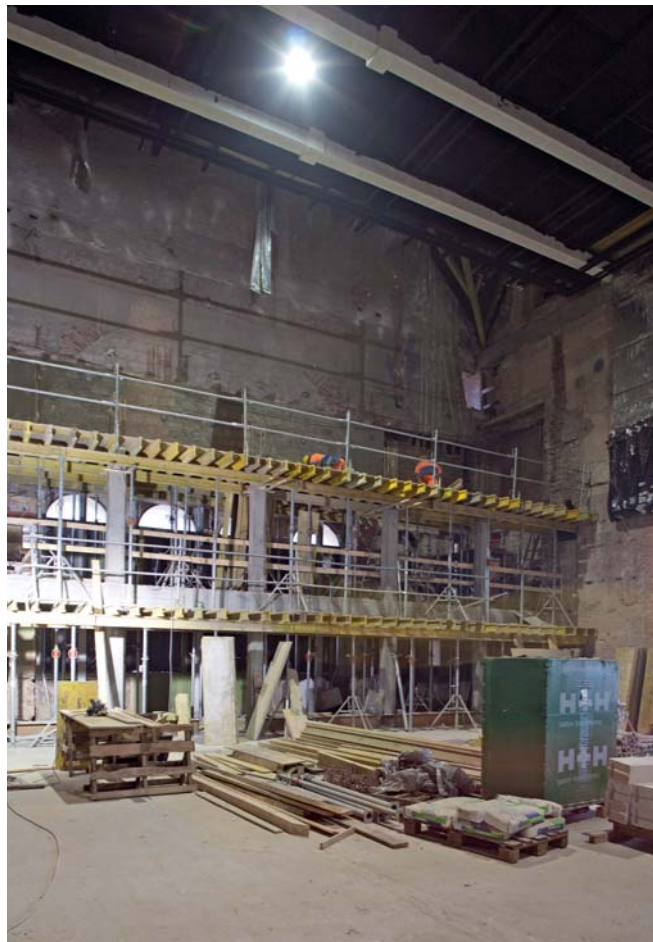
Sala Wielka – projektownia
