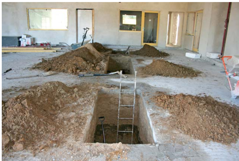
Wykonawcy budowlani otrzymują konkretne wymagania od producentów podnośników
