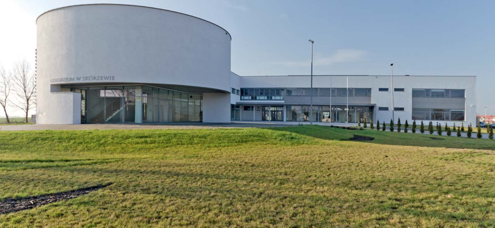
Budynek Gimnazjum w Skórzewie od strony rozwidlenia dróg (elewacja wschodnia)
