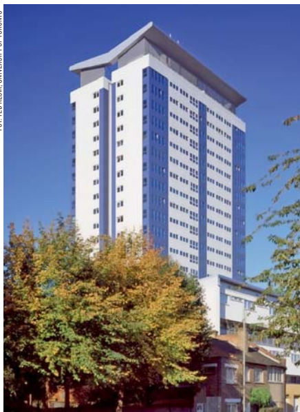
Przykład kompletnie obudowanych balkonów w Wielkiej Brytanii
